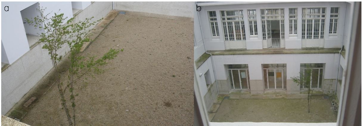
Figura 29 - Pátio interior da EBSRF, vista do piso 0
