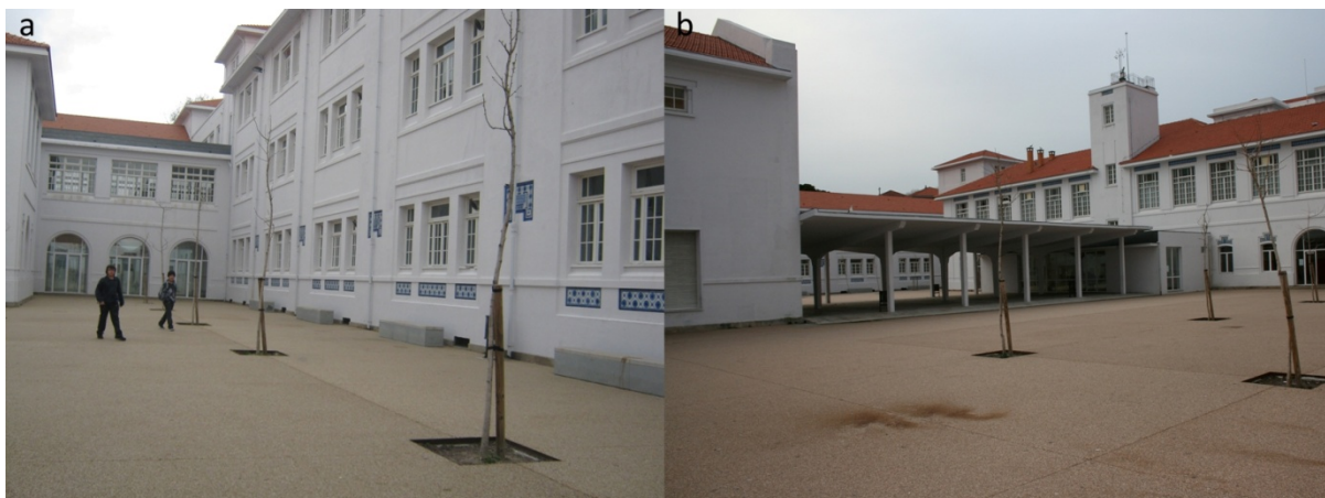
Figura 21 - Pátio interior nascente (Figura 21a – vista do pátio interior nascente, Figura 21b – Vista do pátio interior nascente, enquadrando o telheiro entre o bar, o CRE e o pátio interior poente)
